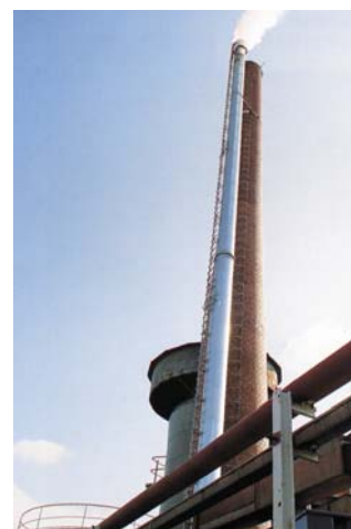
Типоряд FSB Статика Опираие на кирпичную Поверхность дымовую трубу Облицовка из оц. стали
