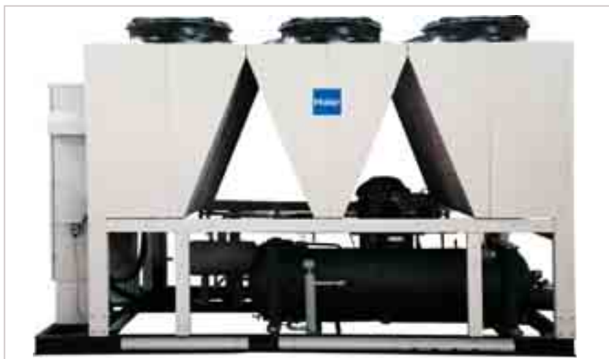
Чиллер с воздушным охлаждением конденсатора с компрессором на магнитном подвесе
