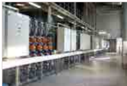
Рис. 7. Узел дозирования гипохлорита натрия
