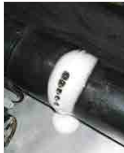
Место утечки, обработанное пеной
