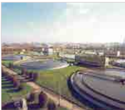
Рис. 10. Курьяновские очистные сооружения. Отстойники
