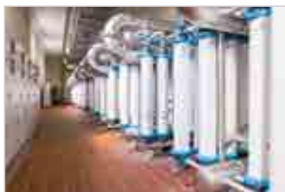
Рис. 2. Юго-Западная водопроводная станция. Мембранный блок
