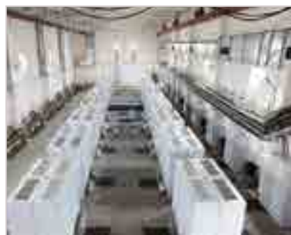
Рис. 14. Люберецкие ОС. Отделение установки модулей УФ-обеззараживания
