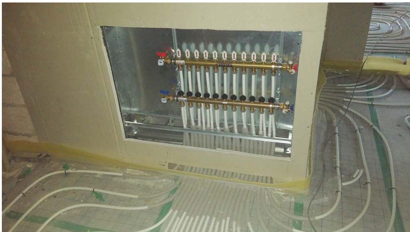
Рис. 2. Подключение труб теплого пола к коллекторному шкафу
