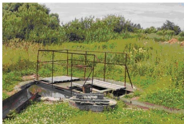
Рис.2. Сооружения биологической очистки с прикрепленной микрофлорой на загрузке ершового типа, используемые в качестве контактных резервуаров
