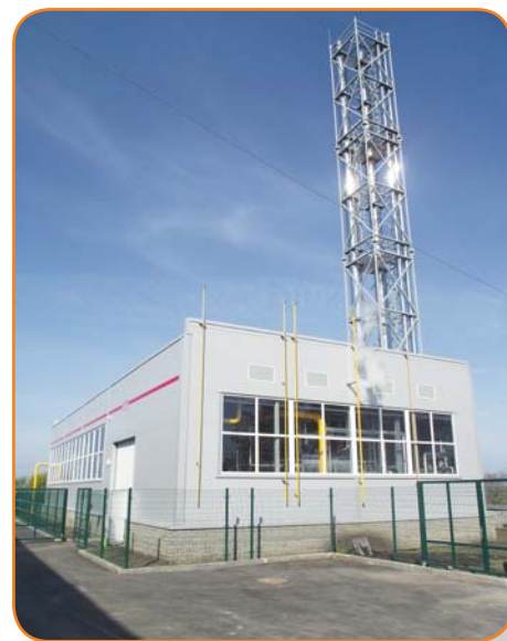
Рис. 1. Пароводогрейная котельная для нужд областной больницы им. Семашко (г. Н. Новгород, ул. Родионова). Водогрейная мощность 13 МВт и паро-производительность 1 т/ч
