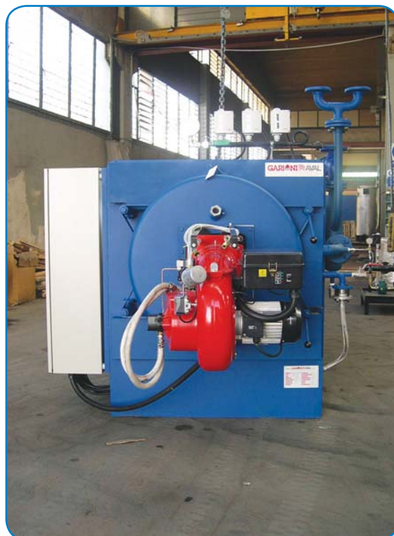
Водотрубный трехходовый змеевиковый парогенератор Garioni Naval
