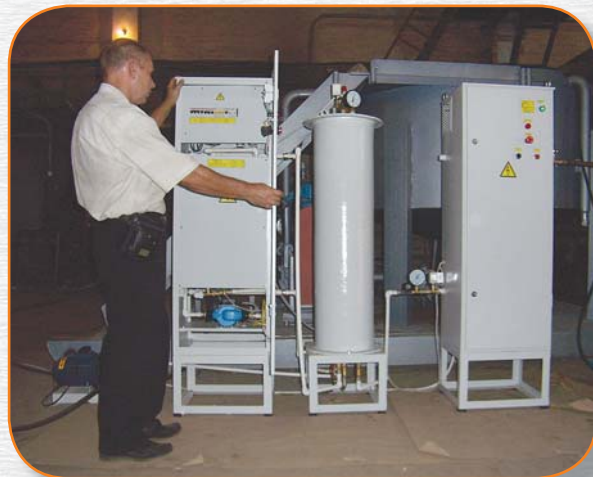
Рис. 1. Индукционный электропарогенератор ЭПГ-И завода нестандартного энергетического оборудования «СТРИМ» (Ростов-на-Дону)
