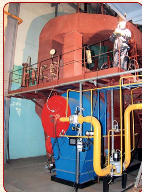
Реконструкция котла ДЕ 25-14-225ГМ в паровой котельной (ФГАОУ ВПО «УрФУ имени первого Президента России Б.Н.Ельцина»)
