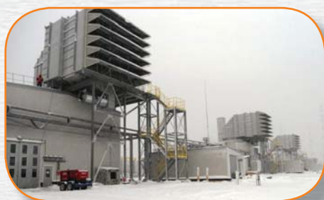
Рис. 3. Комплексное воздухоочистительное устройство на газотурбинной установке
