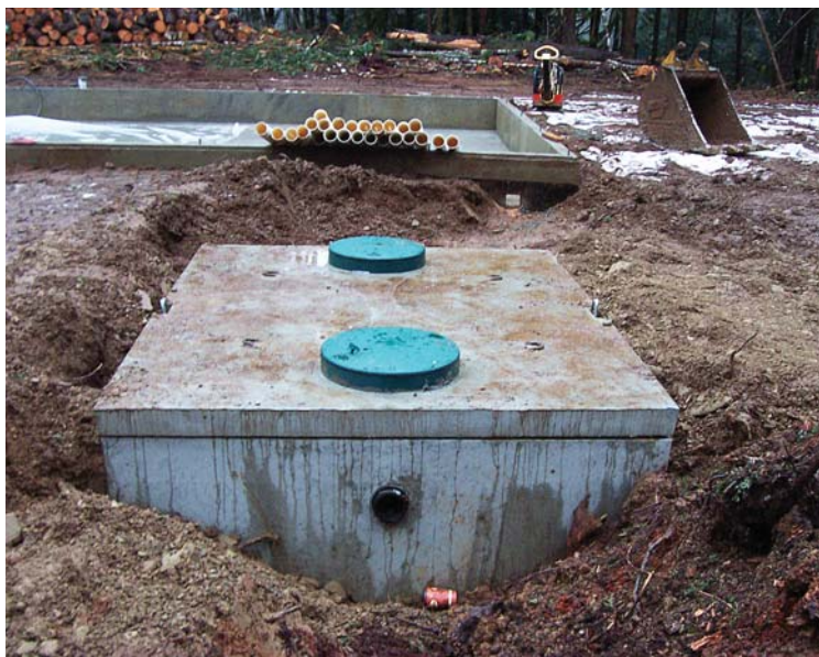
Монтаж двухкамерного септика в бетонном корпусе
