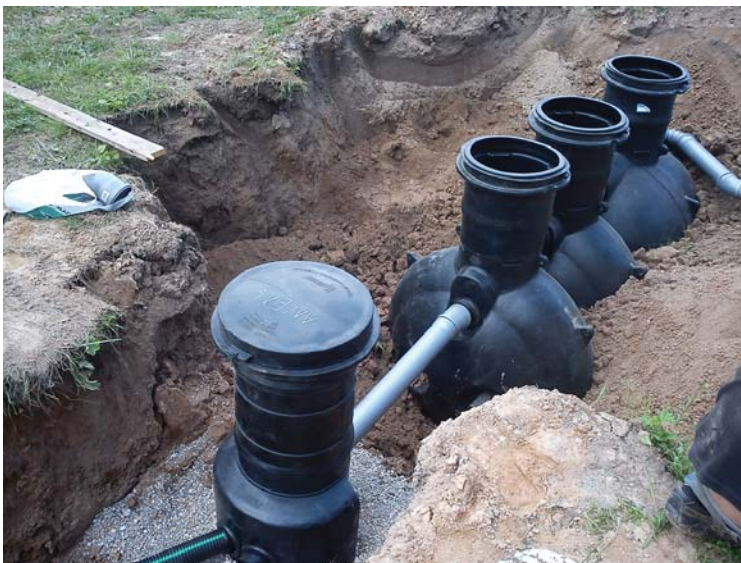
Монтаж трехкамерного септика с фильтрующим колодцем
