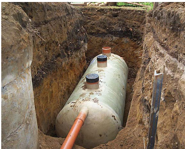
Монтаж трехкамерного септика в пластиковом корпусе
