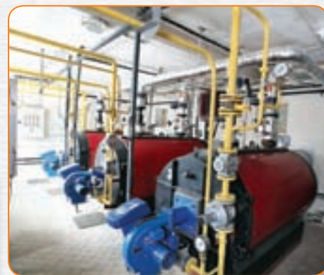
Рисунок 7. Водогрейные котлы ЗИОСАБ-500 в многокотловой установке
