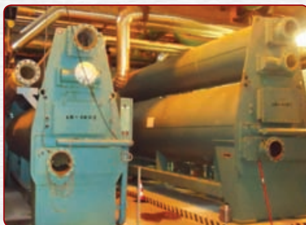
Рис. 5. Абсорбционная холодильная машина фирмы YORK (Johnson Controls, США)
