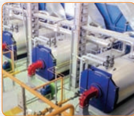
Рисунок 6. Многокотловая установка с водогрейными котлами «Энтророс»
