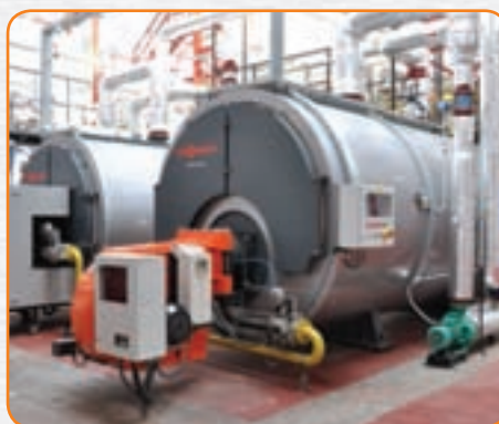
Рисунок 3. Водогрейный котел Viessmann VITOMAX 200-LW
