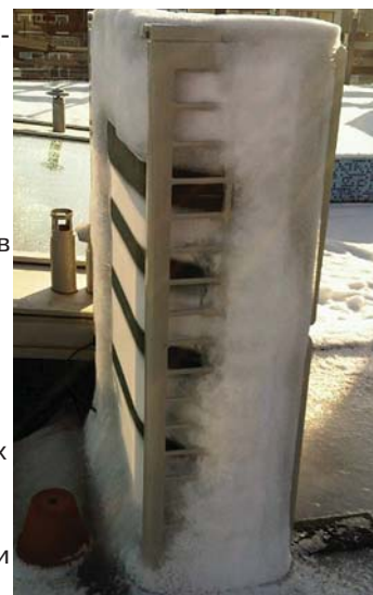
Рис. 3. Обмерзание наружного блока
