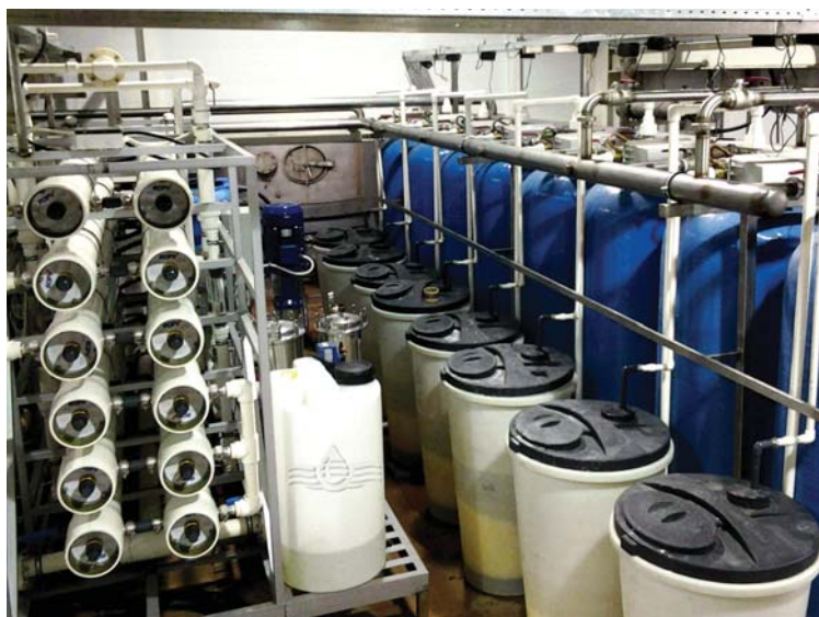
Установка ультраfiltrации
