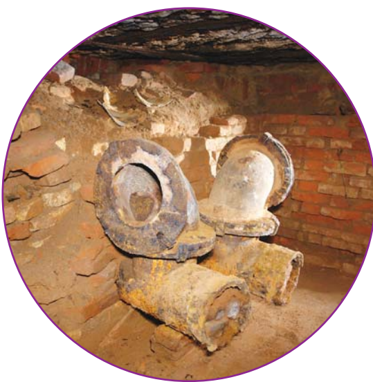
Воздушная камера амосовской печи — чугунные газоходы
