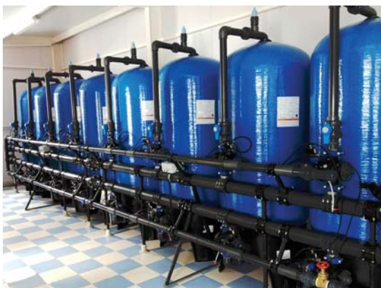
Рис. 1. Станция обезжелезивания воды промышленной производительности
