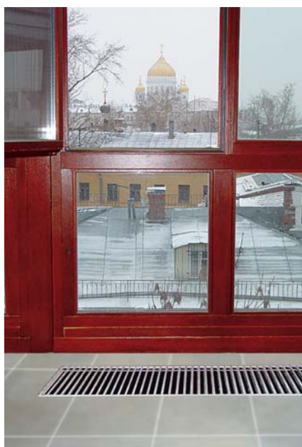
Рис. 1. Встроенные в пол конвекторы – оптимальное решение для размещения отопительного прибора под низкими окнами
