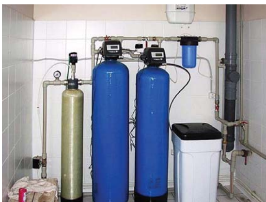
Рис. 4. Бытовая установка обезжелезивания воды
