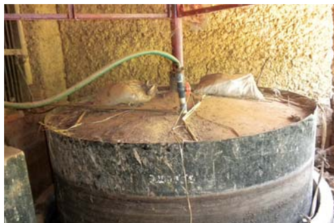
Рис. 6. Тепло-гидроизоляция ферментатора
