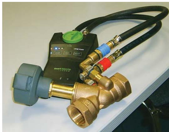
Рис. 4. Подключение прибора
