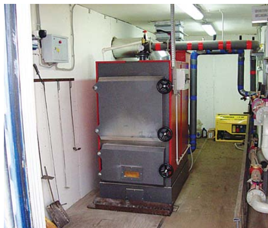
Рис. 2. Обвязка пеллетного котла
