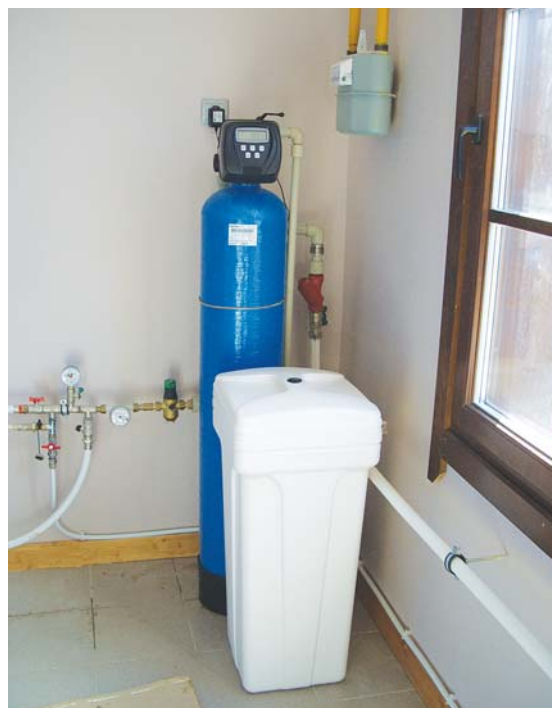
Рис. 4. Установка умягчения воды
