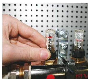
Рис. 11. Настройка расхода в петле по ротаметру
