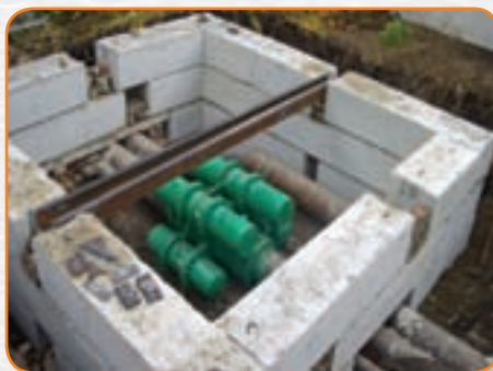
Стабилизатор давления на прямой сетевой воде
