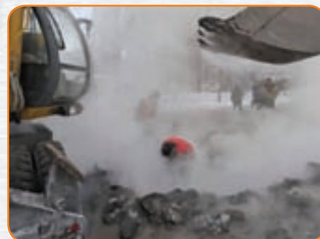
Вскрытие места разрыва трубопровода
