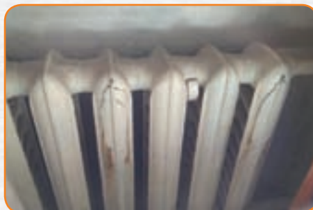
Разрушение чугунного радиатора от гидравлического удара
