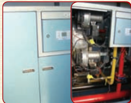
Котловая установка КТГМ (конденсационный теплогенерирующий модуль) мощностью от 1 до 3 МВт, разработанная ЗАО «Мосинтерм»
