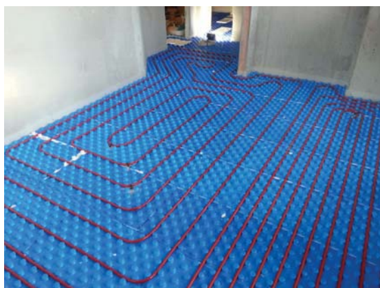
Рис. 1. Монтаж системы теплого пола
