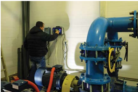
Рис. 7. Пусконаладочные работы на ВЗУ г. Новомосковск, МО
