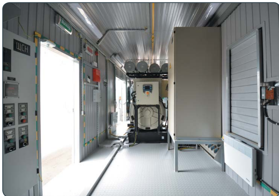
Две электростанции GMGen Power Systems GMC2200 (3200 кВт) с двигателями Cummins для объекта Каспийского Трубопроводного Консорциума
