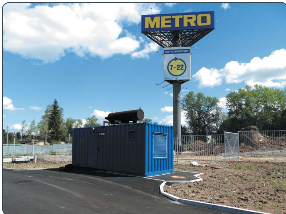
Электростанция GMGen Power Systems GMP550 (440 кВт) с двигателем Perkins для объекта оптового гипермаркета Metro C&C
