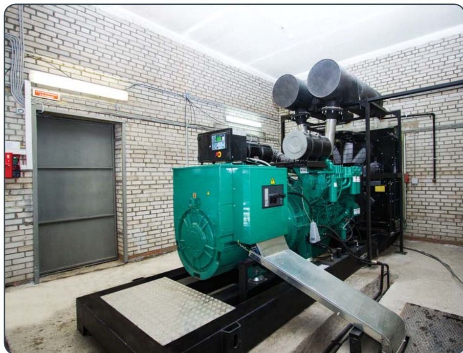
Электростанция GMGen Power Systems GMC1100 (800 кВт) с двигателем Cummins для фармацевтического предприятия VeroPharm
